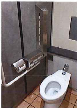
設置された宇都宮駅トイレ
