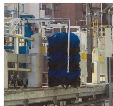
線路側から見た様子
