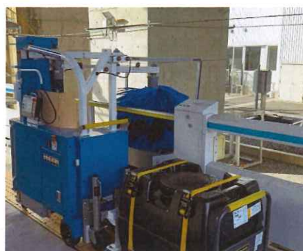
ホーム側から見た様子
