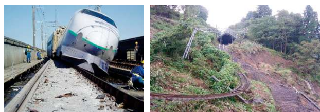
脱線した、「とき325号」最後尾車両 上越線の被害状況（JR東日本資料より）
